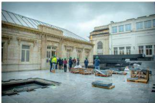
Le patio, entre le bâtiment historique et l'aile contemporaine, à l'arrière. ©EDA
